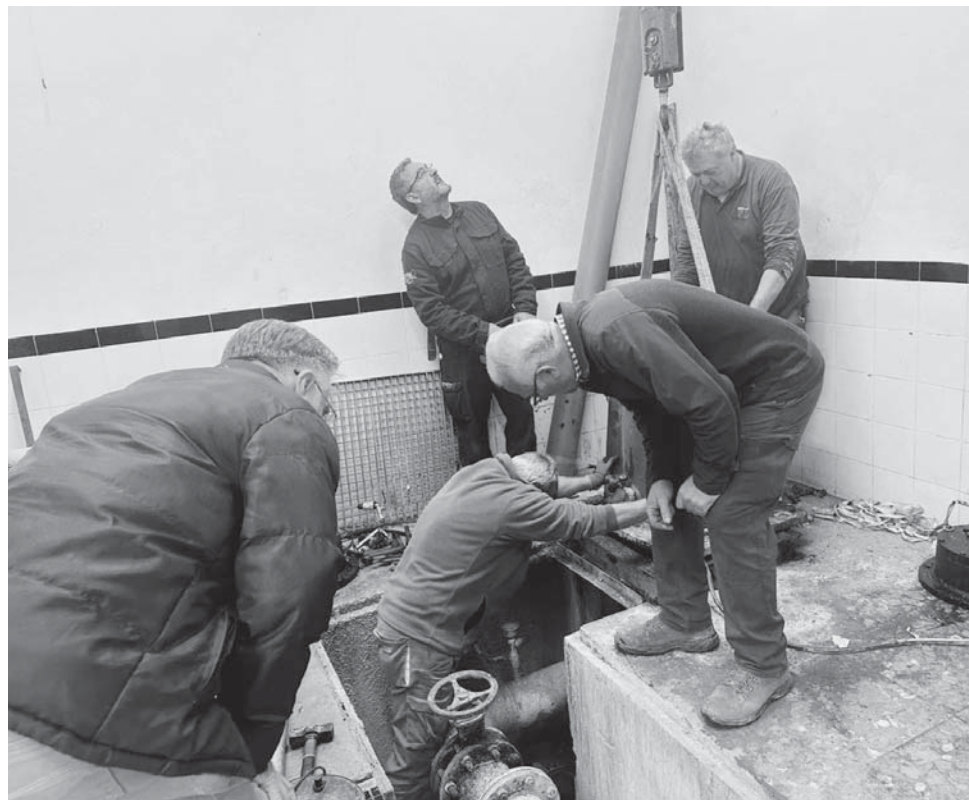
Operarios durante la intervención para la reparación de la avería en el depósito de agua.
