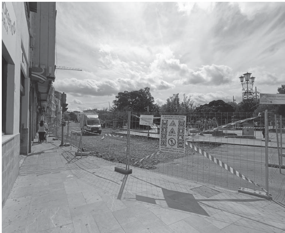
Vallas a la altura del Pilar de los Álamos, por las obras en la vía, este martes.
