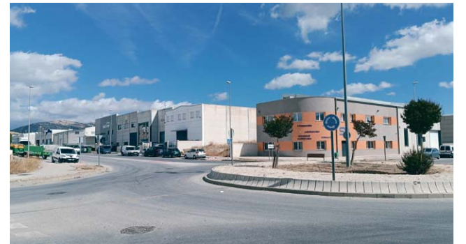
Naves en el Polígono industrial de Llano Mazuelos.
