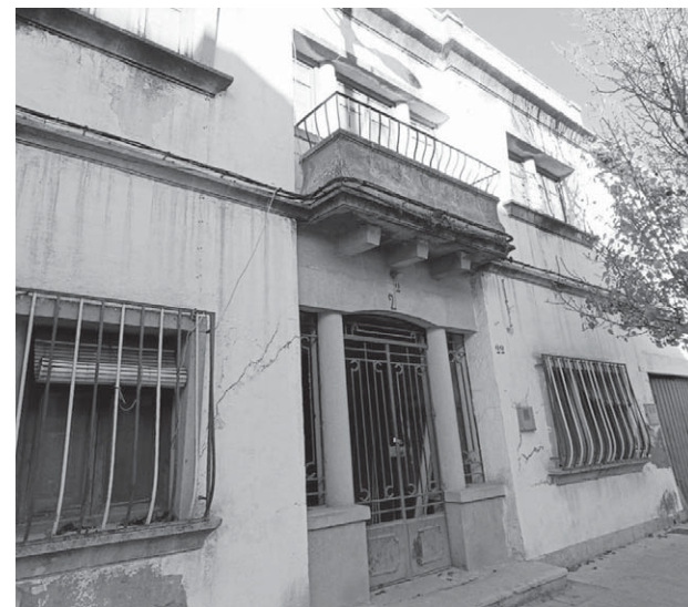
Edificio en el que se construirán los nuevos juzgados.
